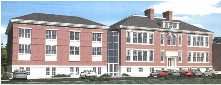
Renovada antigua escuela de Spalding
